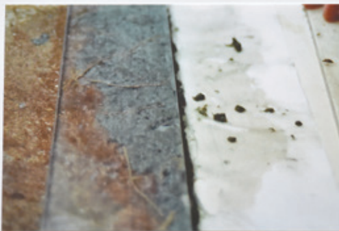
Mit Papierpulpe u. Hanffasern werden die Fehlstellen der Rippen ergänzt
